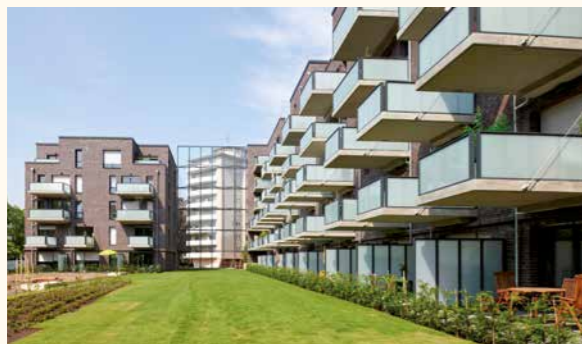
Die große Fensterfront zwischen den Wohneinheiten flutet Licht in den Innenhof der Anlage und wirkt zusätzlich schalldämmend.
