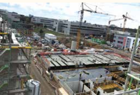
Aktuelle Baustellenfotos des Neubaus auf dem Schlösser-Areal in Düsseldorf-Derendorf
