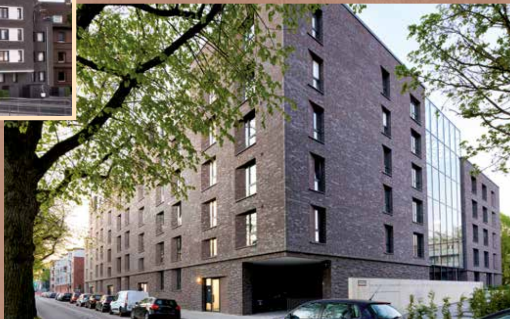
Das fertige Neubauprojekt Hansaallee 55-61a
