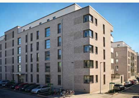
Aktuelle Fotos des fertigen Neubaus Schlösser-Areal in Düsseldorf-Derendorf
