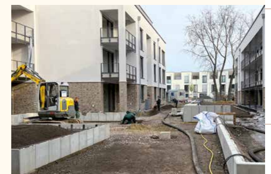
Aktuelle Baustellenfotos des Neubaus Johannes-Weyer-Straße in Düsseldorf-Bilk
