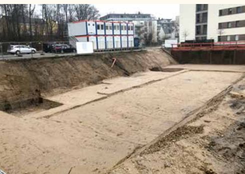
Aktuelle Baustellenfotos des Neubaus Jakobus-Quartier in Düsseldorf-Gerresheim
