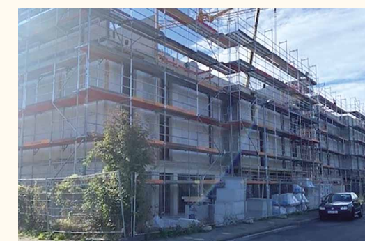
Aktuelles Baustellenfoto des Neubaus Verweyenviertel in Düsseldorf-Kaiserswerth
