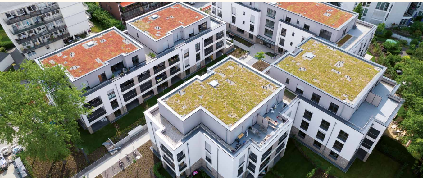
Aktuelle Luftaufnahme des fertigen Neubaus Johannes-Weyer-Straße in Düsseldorf-Bilk
