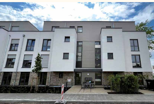
Aktuelles Foto des fertigen Neubaus Johannes-Weyer-Straße in Düsseldorf-Bilk
