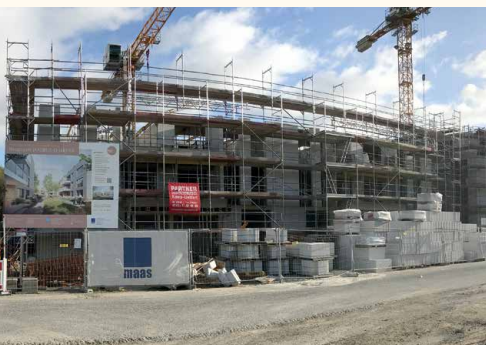
Aktuelles Baustellenfoto des Neubaus Jakobus-Quartier in Düsseldorf-Gerresheim
